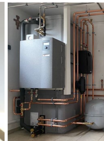
Montagebeispiel mit Anschluss-Set und Hydraulikmodul
